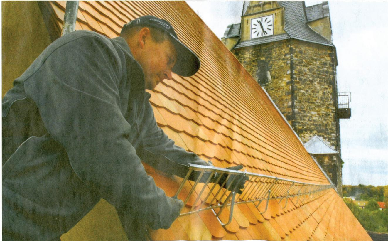
Dachdecker Steffen Pfeifer bei den Restarbeiten auf dem Lützener Kirchendach. Er montiert hier ein Schneegitter. Durch die Nessaer Firma von
